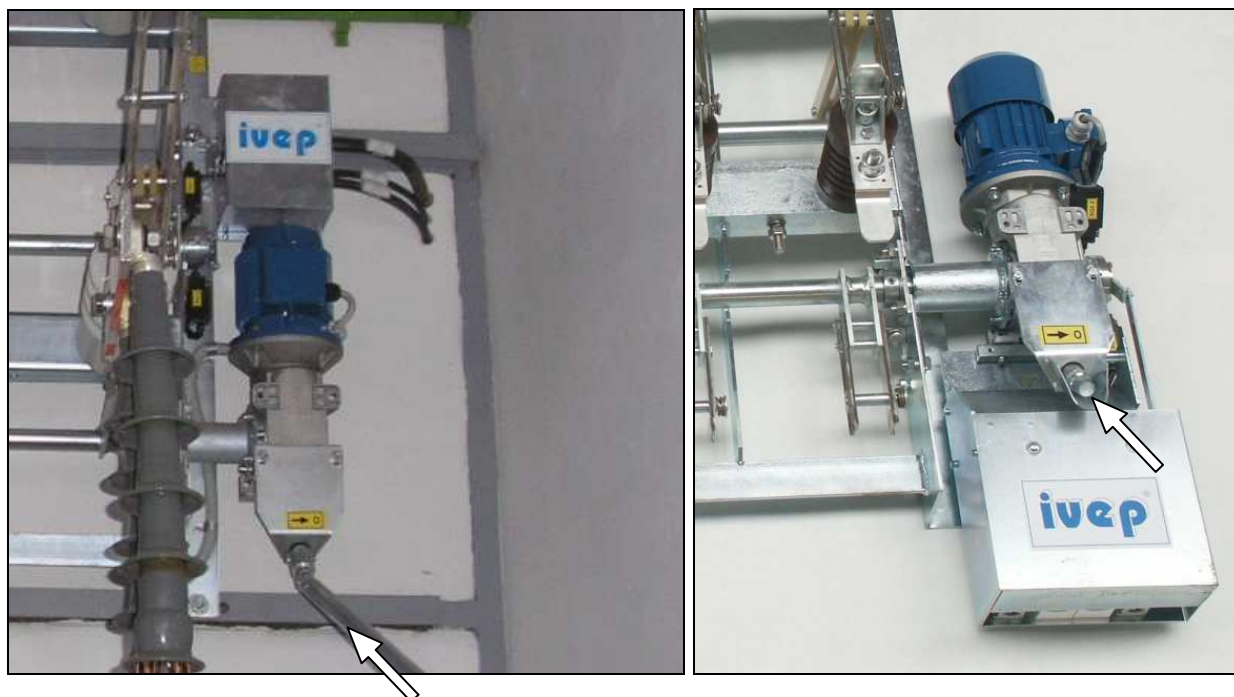
Příklady vyvedení nouzového ovládání u vnitřních přístrojů Examples of emergency control output for indoor devices
