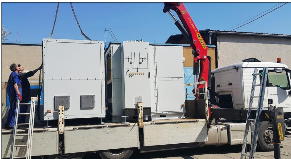
Modulární provedení. Dělení na sekce pro snadnou dopravu.
