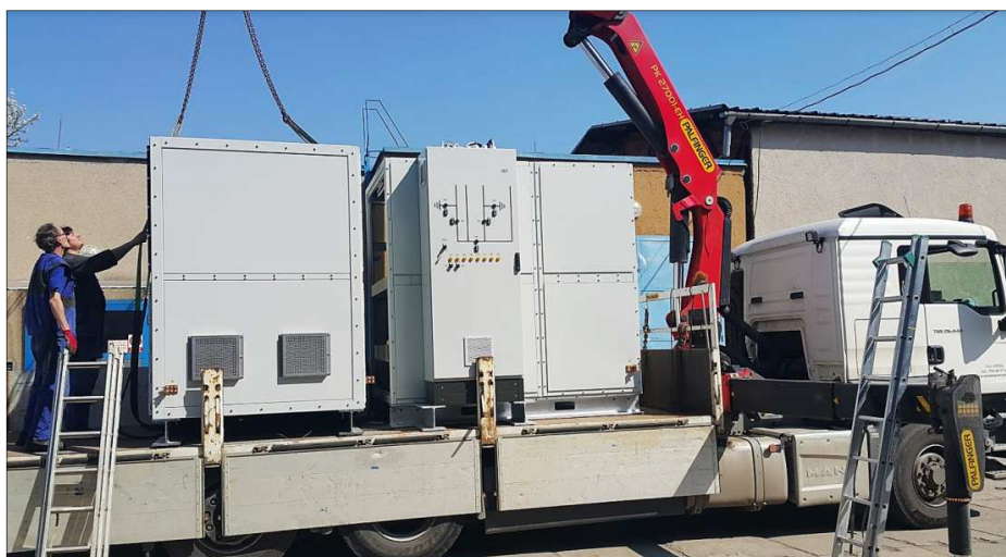
Modulární provedení. Dělení na sekce pro snadnou dopravu Modular design. Splitting the switchgear into sections for easier transport.
