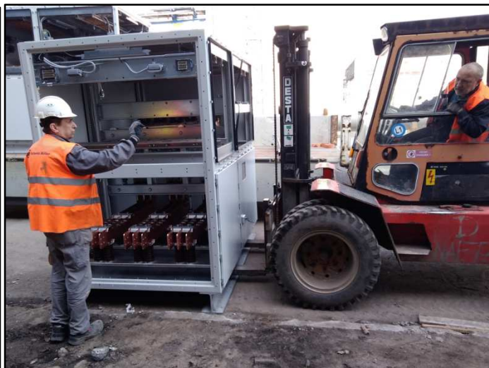
Examples of lashing and lifting the switchboard cabinets Příklady vázání a zvedání rozváděčů
